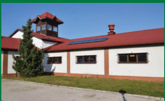
Mikroinstalacja fotowoltaiczna na budynku WCIE
