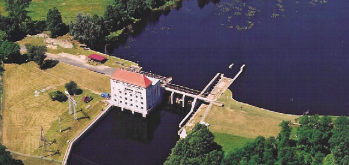
fol. Enea Mała elektrownia wodna w Dobrzycy
