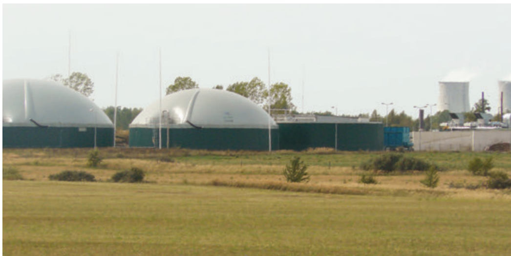
fol. Ewa Kwapich Biogazownia rolnicza w Psarach, a w tle konwencjonalna elektrownia Adamów w Turku
