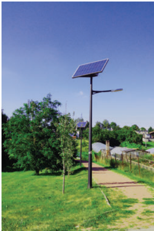
fot. Przemysław Kijewski Oświetlenie fotowoltaiczne
