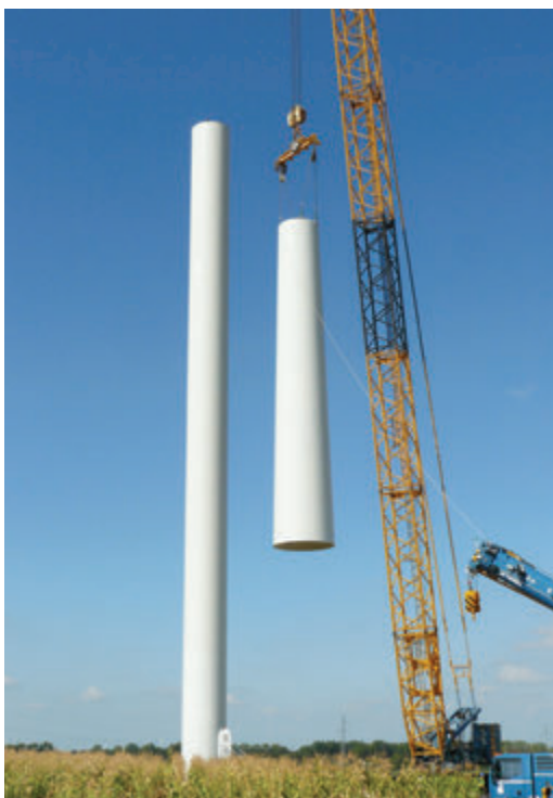
fol. Ewa Kwapich Farma wiatrowa w Józwinie podczas budowy wieży
