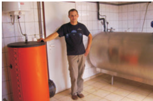
foto. Wioletta Kmiećkowiak Odzysk ciepła ze schładzanego mleka w gospodarstwie Mateusza Gąda w Jerzycach Kościelnych
