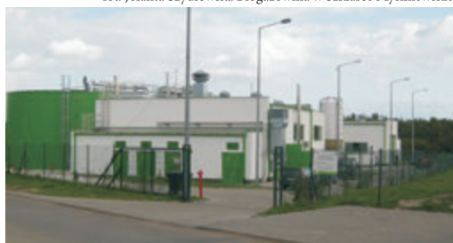
fol. Ewa Kwapich Biogazownia w Skrzatuszu
