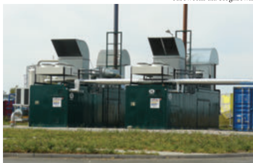
fol. Ewa Kwapich Silniki kogeneracyjne w biogazowni w Psarach
