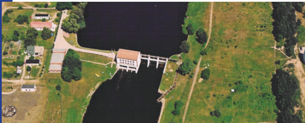
fol. Enea Mała elektrownia wodna Koszycy
